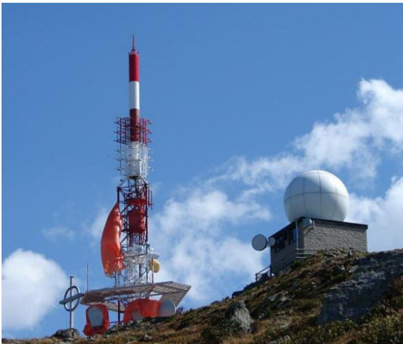
Abbildung: ORS-Sendeanlage Patscherkofel mit APOS-Referenzstation
